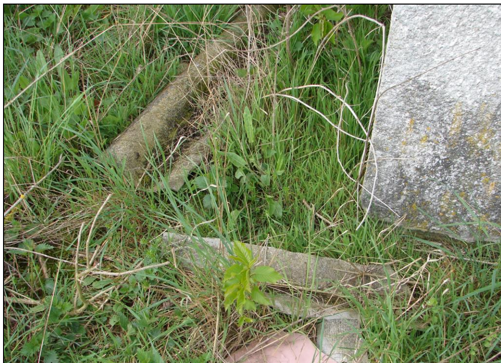
Foto 25: SO 09-45-01 výhybna Straky, přístřešek; okolí přístřešku, vlnité desky na bázi cementu vlevo od přístřešku při pohledu od trati, vlnité desky na bázi cementu obsahují azbestová vlákna
