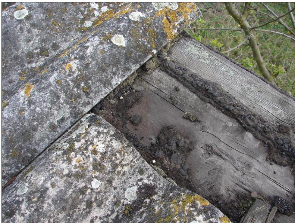
Foto 20: SO 09-45-01 výhybna Straky, přístřešek; střecha, pod vlnitými deskami na bázi cementu a asfaltovou lepenkou je dřevěné bednění
