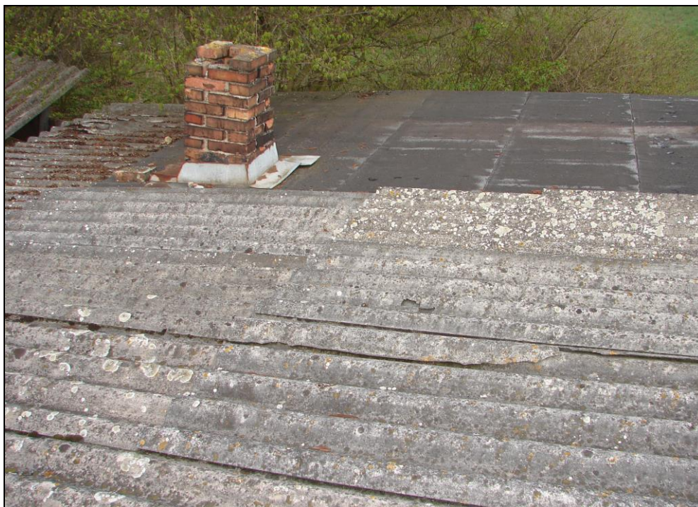
Foto 19: SO 09-45-01 výhybna Straky, přístřešek; střecha, vlnité desky na bázi cementu, vlnité desky na bázi cementu obsahují azbestová vlákna , na části střechy vlnité desky chybí, desky byly nalezeny v okolí přístřešku a v zazděné místnosti (foto 14, 25 a 26)
