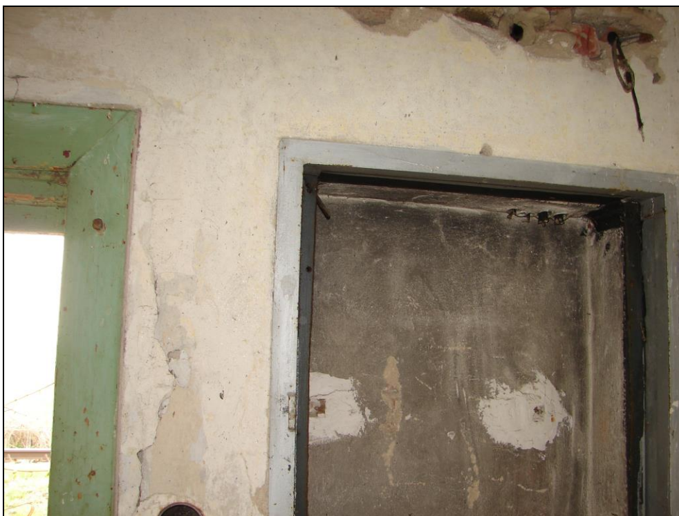
Foto 10: SO 09-45-01 výhybna Straky, přístřešek; místnost volně přístupná směrem od trati, zděná omítnutá stěna, dřevěná zárubeň, ocelový rám niky
