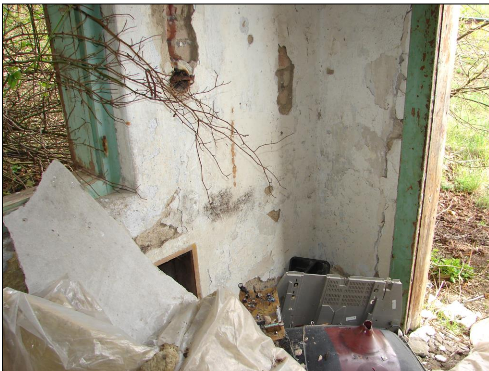
Foto 9: SO 09-45-01 výhybna Straky, přístřešek; místnost volně přístupná směrem od trati, zděné omítnuté stěny, dřevěné okno a dřevěná zárubeň, na podlaze silná vrstva komunálního odpadu (materiál podlahy nelze zjistit)
