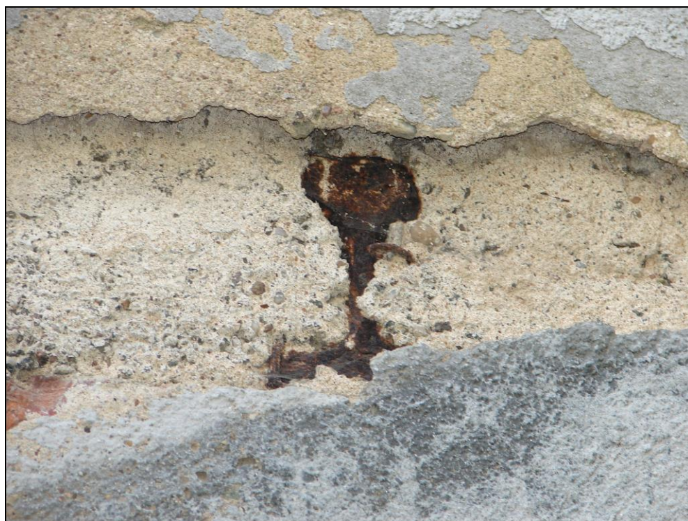
Foto 53: SO 11-45-01, ŽST Čachovice, stavědlo č. 2, 1.PP, fasáda směrem od trati, patrná je železniční kolejnice stropu nad 1.PP
