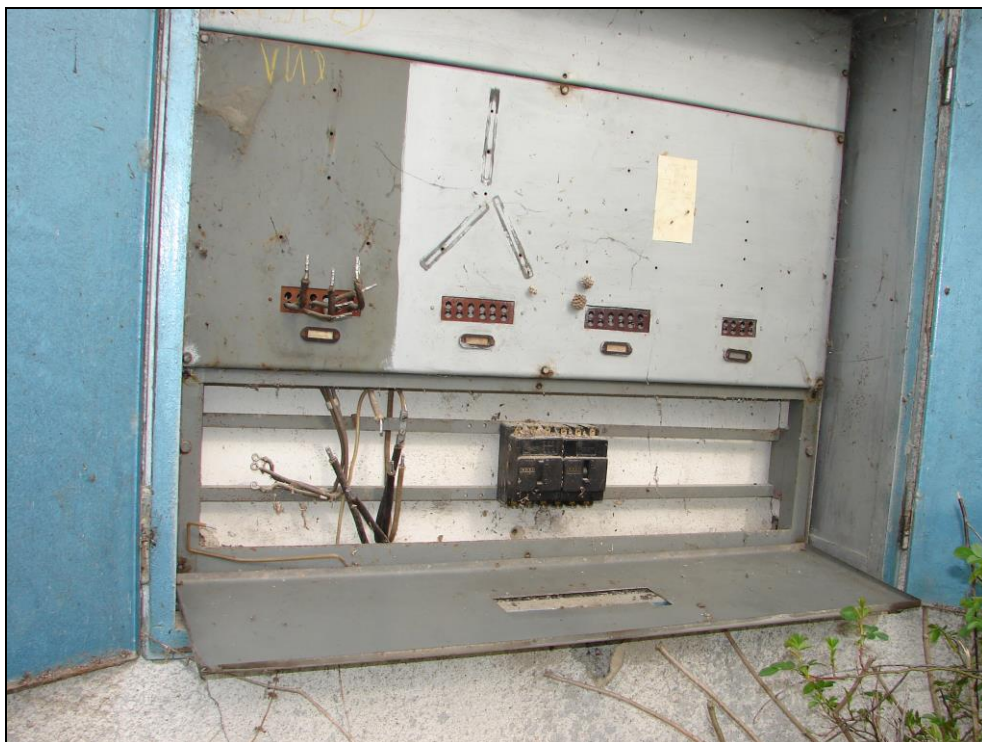
Foto 15: SO 09-45-01 výhybna Straky, přístřešek; rozvaděč el. energie na fasádě (foto 1 a 3), bez nebezpečných materiálů
