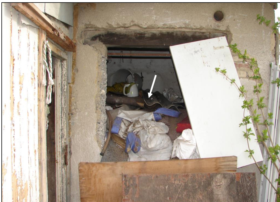
Foto 14: SO 09-45-01 výhybna Straky, přístřešek; okno do místnosti na foto 11 - 13, šipkou vyznačena vlnitá deska na bázi cementu (podrobně viz foto 18 a 19)
