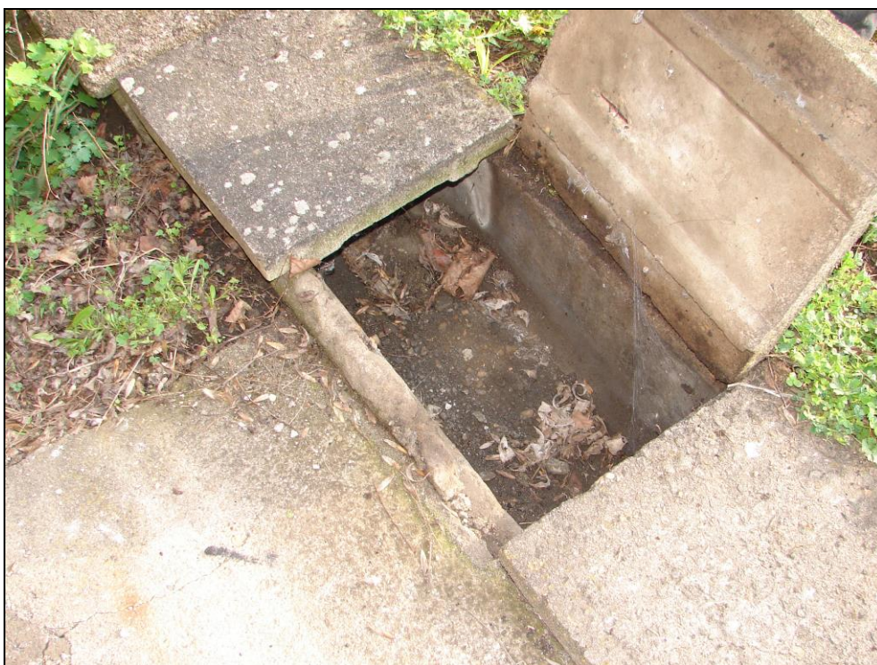
Foto 67: SO 11-45-01, ŽST Čachovice, stavědlo č. 2, okolí objektu, drátovody z betonu zakryté betonovými dlaždicemi
