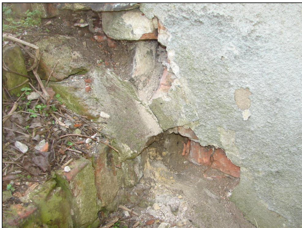
Foto 59: SO 11-45-01, ŽST Čachovice, stavědlo č. 2, 1.NP - 1.PP, sonda pro zjištění spodní izolace v úrovni mezi 1.NP a 1.PP, izolace nezjištěna
