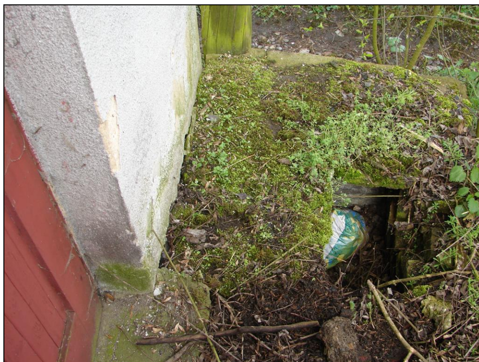
Foto 57: SO 11-45-01, ŽST Čachovice, stavědlo č. 2, 1.PP, rozpadající se zděná jámka suchého záchodu
