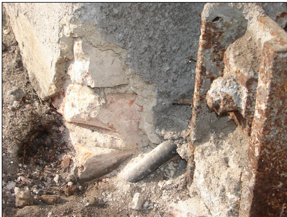
Foto 58: SO 11-45-01, ŽST Čachovice, stavědlo č. 2, 1.NP, sonda pro zjištění spodní izolace v úrovni 1.NP, izolace nezjištěna
