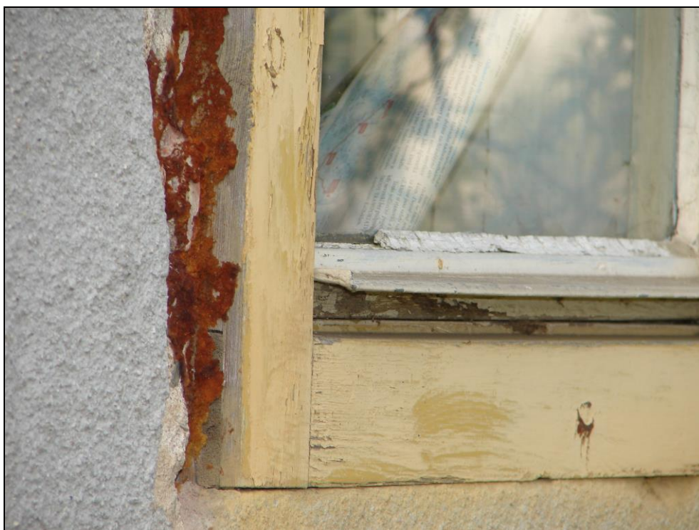
Foto 35: SO 11-45-01, ŽST Čachovice, stavědlo č. 2, dřevěné okno z foto 31, okenní rám utěsněn PUR pěnou
