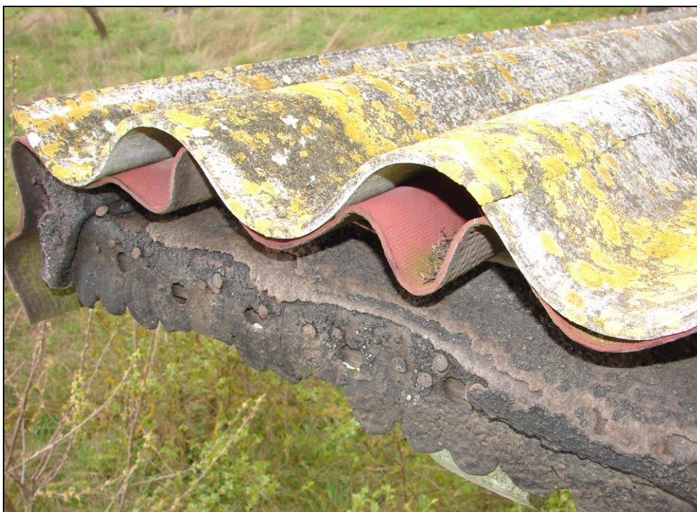
Foto 18: SO 09-45-01 výhybna Straky, přístřešek; střecha, krytinu na dřevěném bednění tvoří asfaltová lepenka, lokálně vlnité bitumenové desky Onduline (cca 2 desky na levé části střechy při pohledu od trati) a vlnité desky na bázi cementu, z vlnité desky na bázi cementu a asfaltové lepenky byly odebrány vzorky (foto 27 a 28), vlnité desky na bázi cementu obsahují azbestová vlákna , asfaltová lepenka neobsahuje azbest jako plnivo
