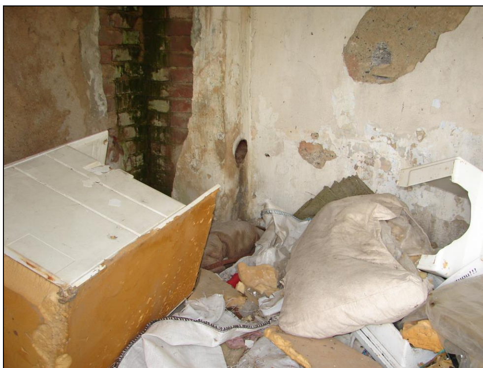
Foto 5 a 6: SO 09-45-01 výhybna Straky, přístřešek; místnost volně přístupná směrem od trati (dveřní otvor vpravo na foto 2), zděné omítnuté stěny, dřevěný strop s omítkou na rákos, na podlaze silná vrstva komunálního odpadu (materiál podlahy nelze zjistit)
