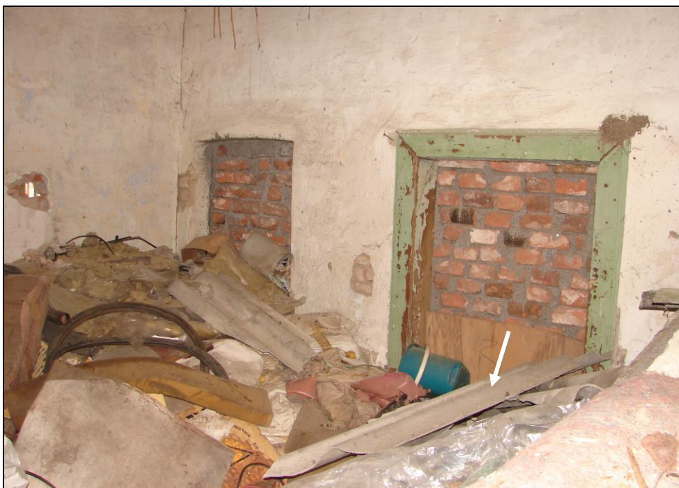
Foto 11 a 12: SO 09-45-01 výhybna Straky, přístřešek; místnost se zarděným oknem a dveřmi, zděné omítnuté stěny, dřevěný strop s omítkou na rákos, dřevěná zárubeň, na podlaze velmi silná vrstva komunálního odpadu (materiál podlahy nelze zjistit), dle [3] vlastník sousední parcely užívá přístřešek jako skládku komunálního odpadu (prohlédnuto oknem z foto 4 a 14) šipkou vyznačena vlnitá deska na bázi cementu (podrobně viz foto 18 a 19)
