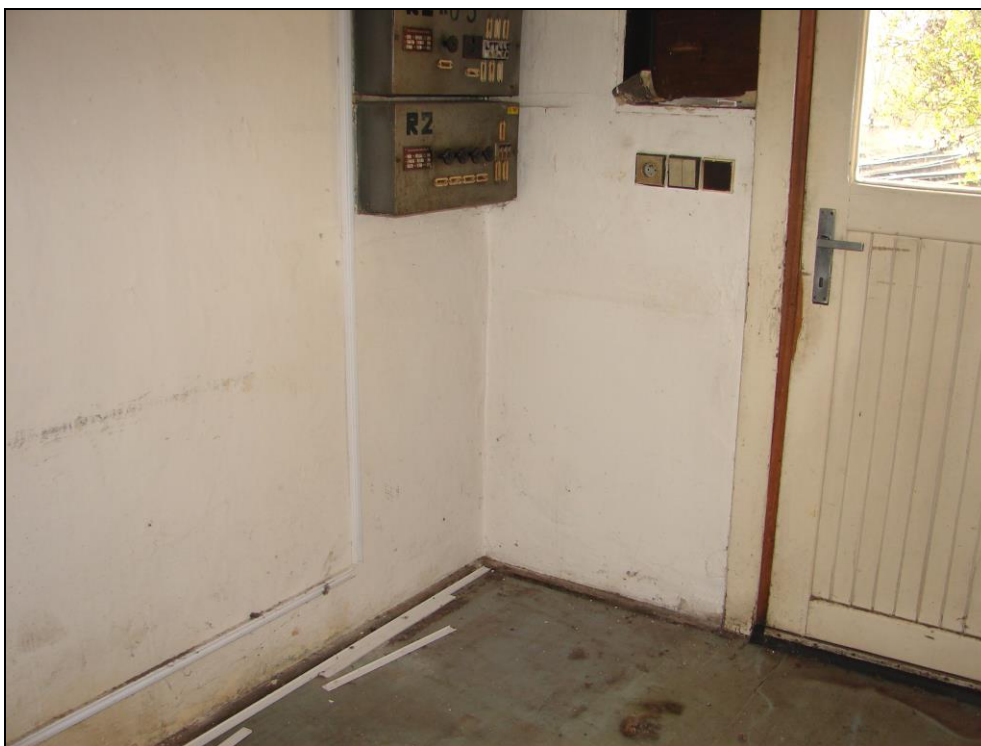
Foto 38 a 39: SO 11-45-01, ŽST Čachovice, stavědlo č. 2, 1.NP, zděné omítnuté stěny, dřevěný strop s omítkou na rákos, dřevěné dveře, na podlaze PVC
