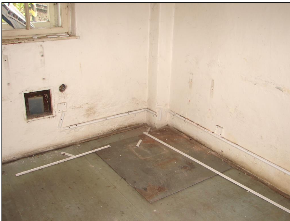
Foto 36 a 37: SO 11-45-01, ŽST Čachovice, stavědlo č. 2, 1.NP, zděné omítnuté stěny, dřevěný strop s omítkou na rákos, dřevěné okno, na podlaze PVC a plech v místech kde stávala kamna (podrobně foto 42, 43 a 69)
