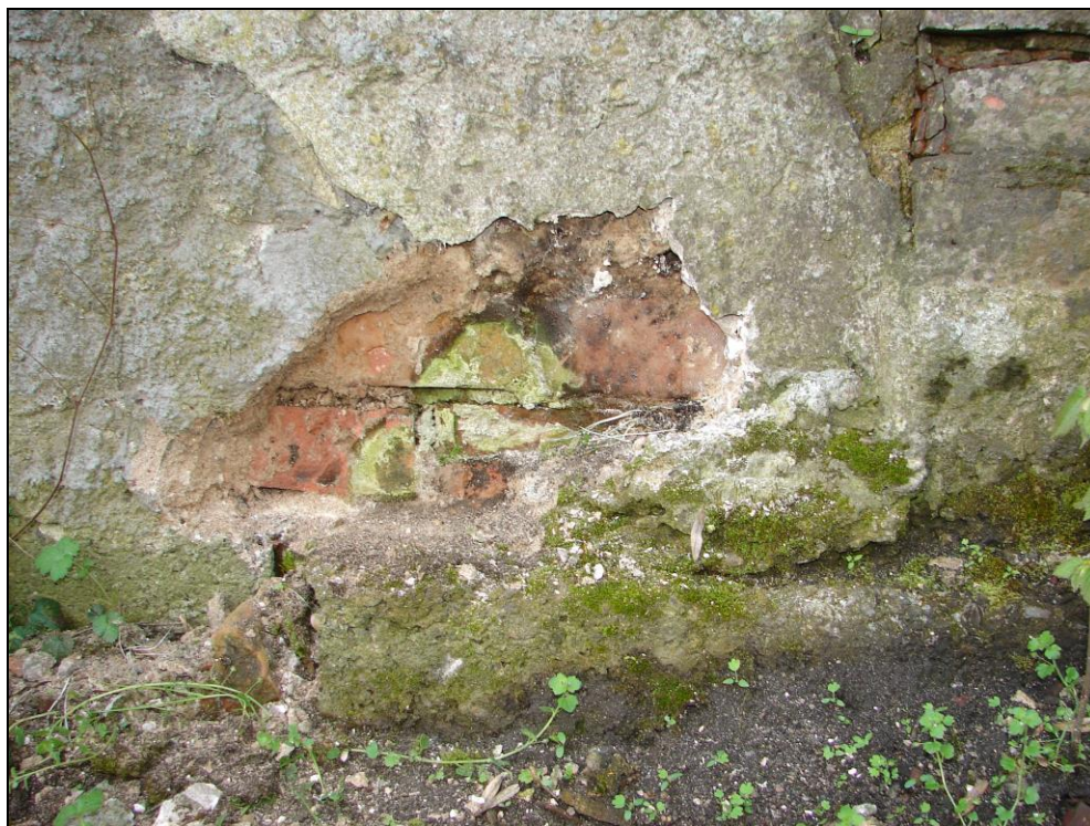
Foto 60: SO 11-45-01, ŽST Čachovice, stavečko č. 2, 1.PP, sonda pro zjištění spodní izolace v úrovni 1.PP, izolace nezjištěna, betonový základ
