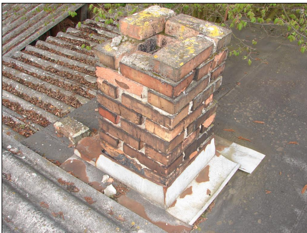
Foto 22: SO 09-45-01 výhybna Straky, přístřešek; střecha, zděný komín s oplechováním
