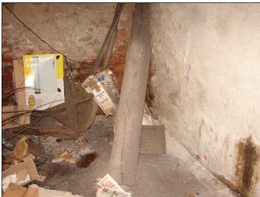
Foto 50 a 51: SO 11-45-01, ŽST Čachovice, stavědlo č. 2, 1.PP, zděné omítnuté stěny, betonový strop do železničních kolejnic (foto 53), betonová podlaha
