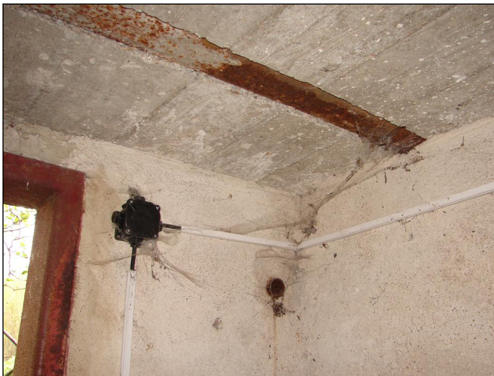
Foto 52: SO 11-45-01, ŽST Čachovice, stavědlo č. 2, 1.PP, zděné omítnuté stěny, betonový strop do železničních kolejnic (foto 53), el. rozvody v plastových lištách
