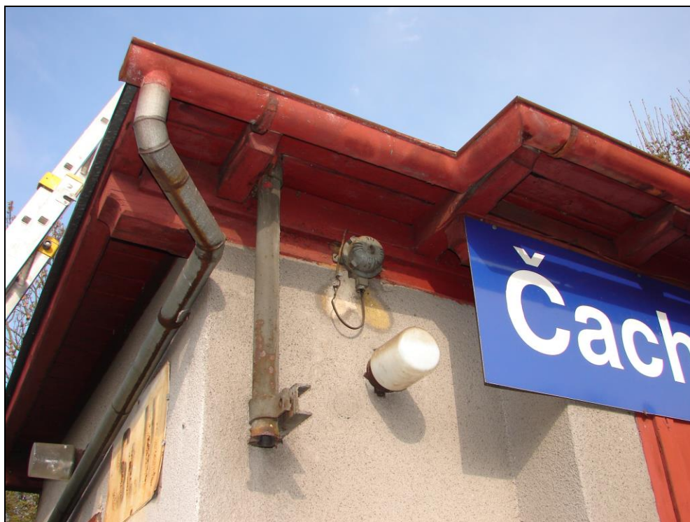
Foto 61: SO 11-45-01, ŽST Čachovice, stavečko č. 2, střecha, dřevěné trámy, dřevěné podbití, plechový okap
