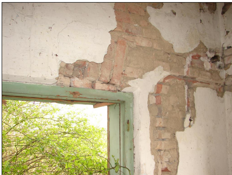
Foto 7 a 8: SO 09-45-01 výhybna Straky, přístřešek; místnost volně přístupná směrem od trati, zděné omítnuté stěny, dřevěný strop s omítkou na rákos, dřevěné okno
