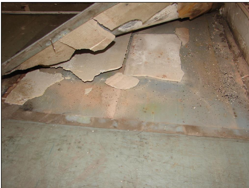
Foto 43: SO 11-45-01, ŽST Čachovice, stavědlo č. 2, 1.NP, pod plechem z foto 42 je deska na bázi cementu, z desky na bázi cementu byl odebrán vzorek (foto 69), deska na bázi cementu obsahuje azbestová vlákna
