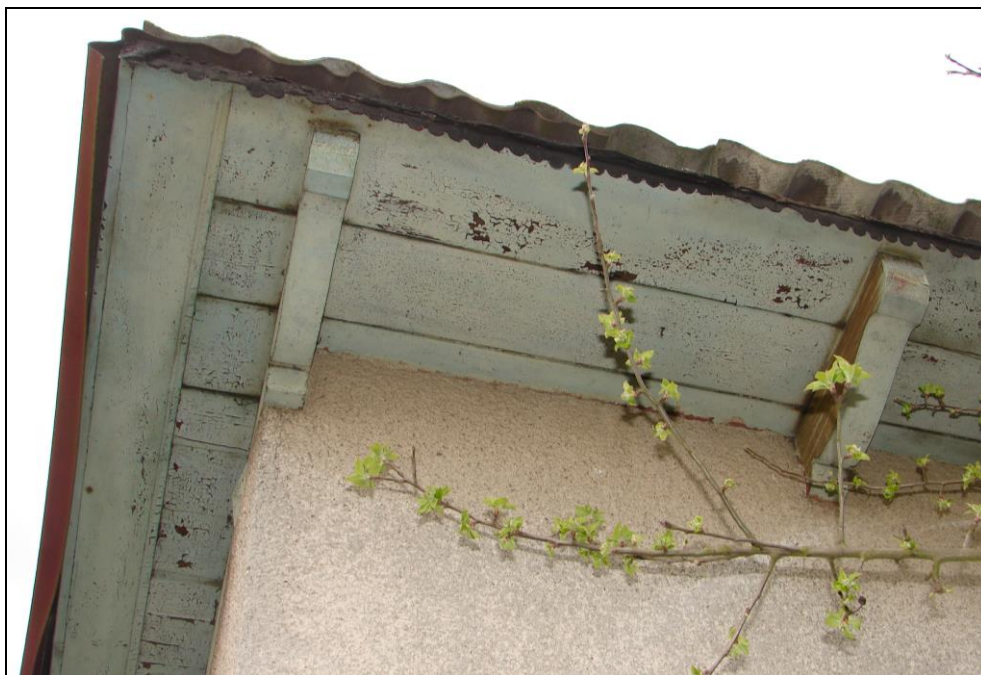
Foto 17: SO 09-45-01 výhybna Straky, přístřešek; střecha (strop), dřevěné trámy a podbití
