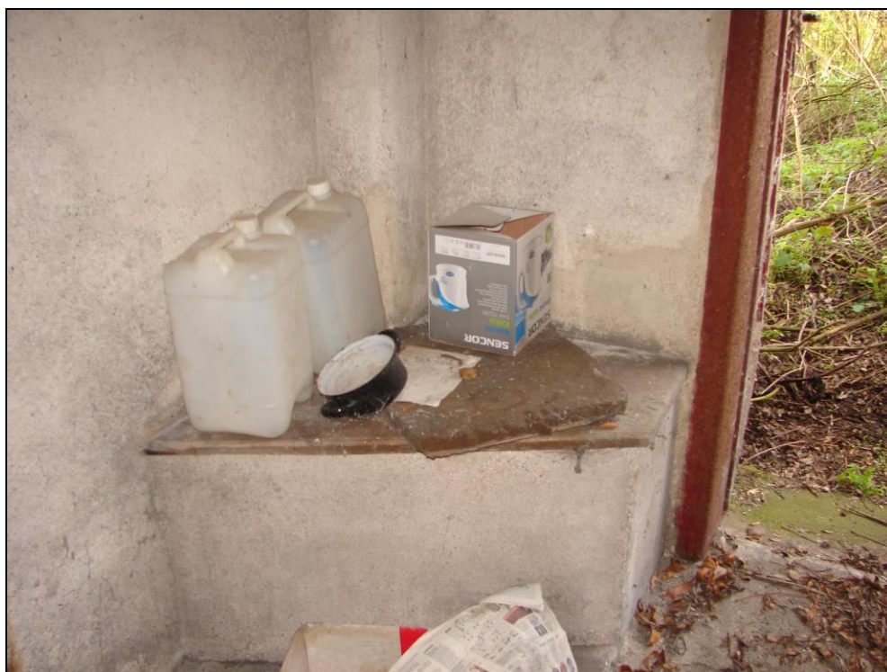
Foto 54 a 55: SO 11-45-01, ŽST Čachovice, stavědlo č. 2, 1.PP, zděné omítnuté stěny, betonový strop do železničních kolejnic (foto 53), betonová podlaha, ocelová zárubeň, v rohu suchý záchod
