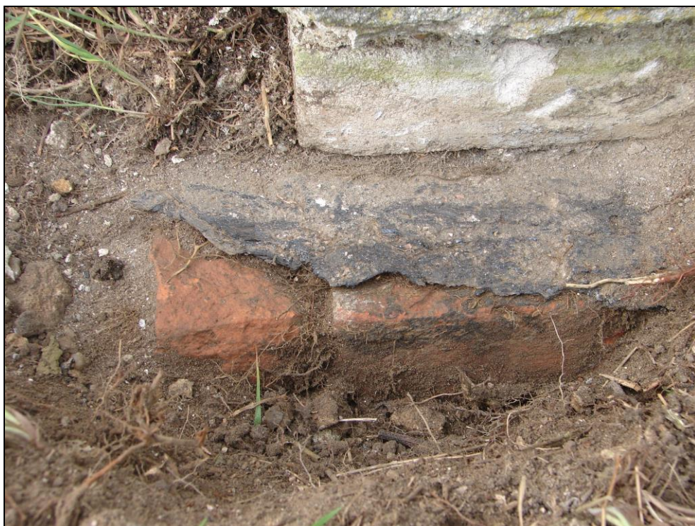
Foto 24: SO 09-45-01 výhybna Straky, přístřešek; střecha, sonda ke spodní izolaci, zděný základový pás, izolaci tvoří dvě vrstvy asfaltové lepenky spojené litým asfaltem, z izolace byl odebrán vzorek (foto 29), asfaltová lepenka neobsahuje azbest jako plnivo, litý asfalt není klasifikován jako nebezpečný materiál
