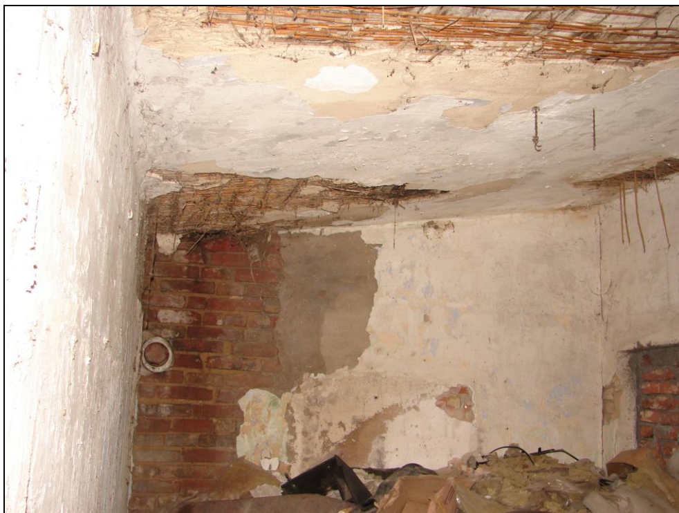
Foto 13: SO 09-45-01 výhybna Straky, přístřešek; místnost se zazděným oknem a dveřmi, zděné omítnuté stěny, dřevěný strop s omítkou na rákos, na podlaze velmi silná vrstva komunálního odpadu (materiál podlahy nelze zjistit), dle [3] vlastník sousední parcely užívá přístřešek jako skládku komunálního odpadu (prohlédnuto oknem z foto 4 a 14)
