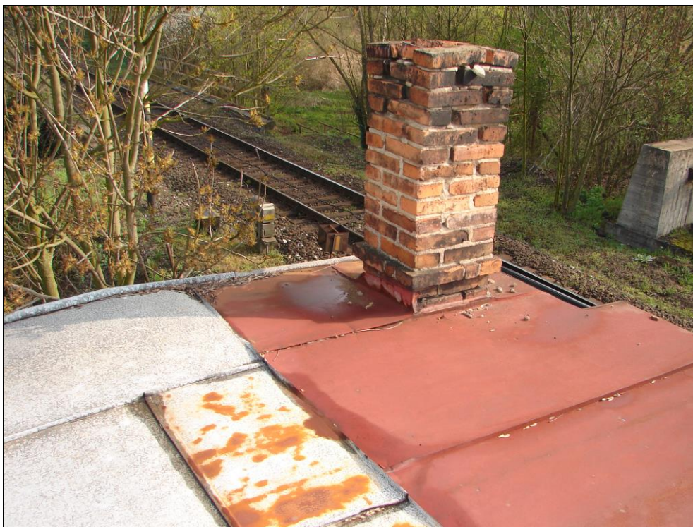
Foto 62: SO 11-45-01, ŽST Čachovice, stavědlo č. 2, střecha, střešní krytina z pozinkovaného plechu (částečně natřená), zděný komín
