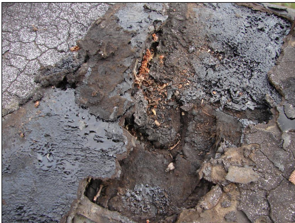
Foto 21: SO 09-45-01 výhybna Straky, přístřešek; střecha, dvě vrstvy asfaltové lepenky spojené litým asfaltem, asfaltová lepenka neobsahuje azbest jako plnivo, litý asfalt není klasifikován jako nebezpečný materiál
