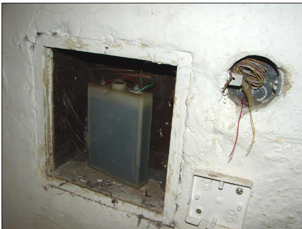
Foto 41: SO 11-45-01, ŽST Čachovice, hradlo č. 2, 1.NP, dřevem obložená nika s malým akumulátorem (foto 37)
