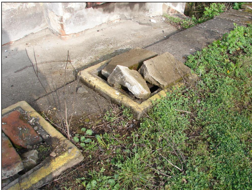
Foto 66: SO 11-45-01, ŽST Čachovice, stavědlo č. 2, okolí objektu, betonová plocha před hradlem, drátovody zakryté betonovými dlaždicemi
