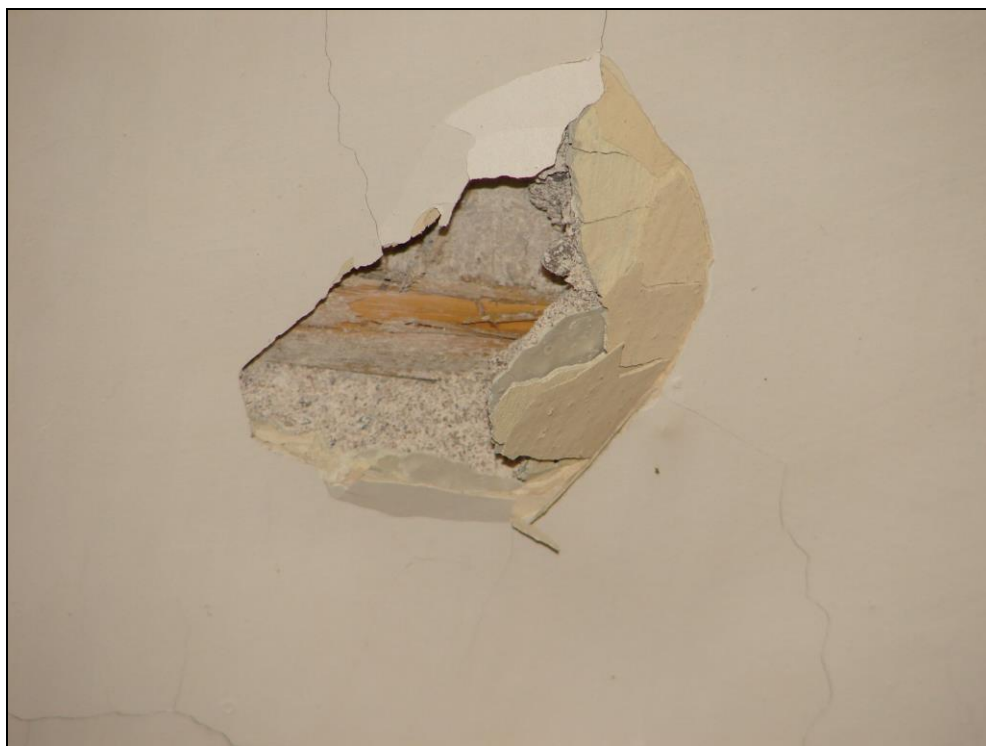
Foto 45: SO 11-45-01, ŽST Čachovice, stavědlo č. 2, 1.NP, lokální sonda do podhledu stropu, dřevěný strop s omítkou na rákos
