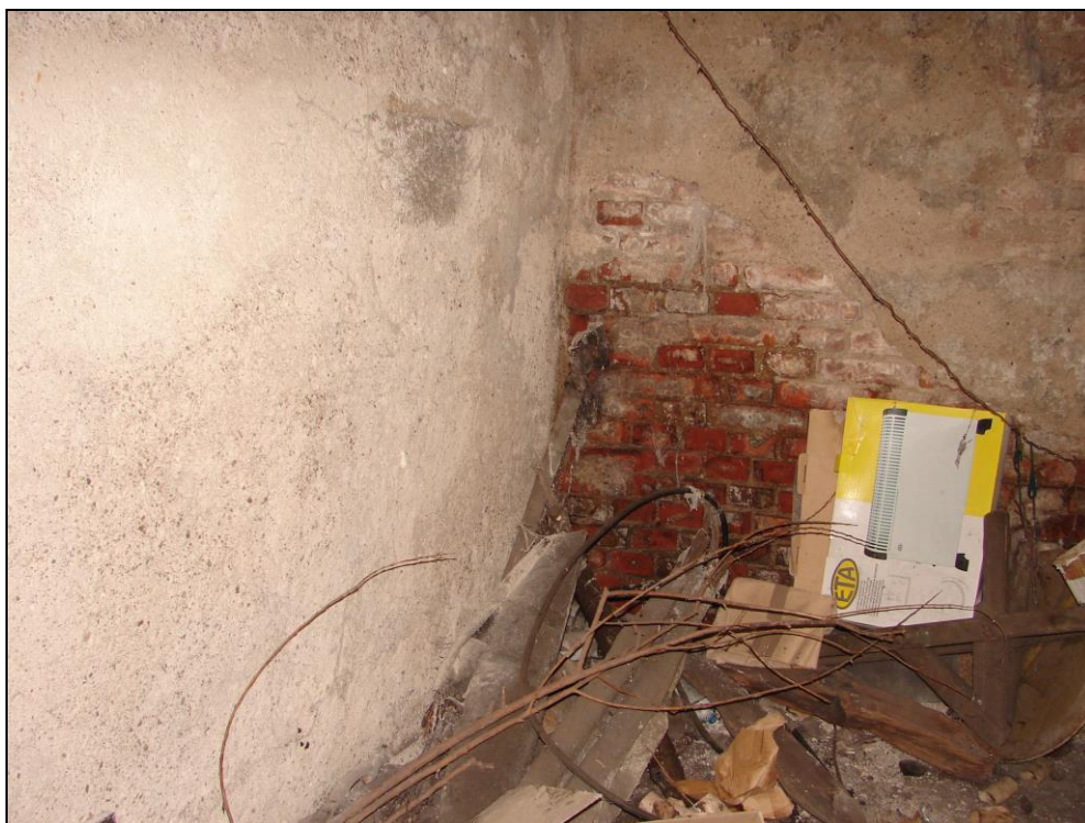
Foto 48 a 49: SO 11-45-01, ŽST Čachovice, stavědlo č. 2, 1.PP, zděné omítnuté stěny, betonový strop do železničních kolejnic (foto 53), el. rozvod v plastové liště (foto nahoře)
