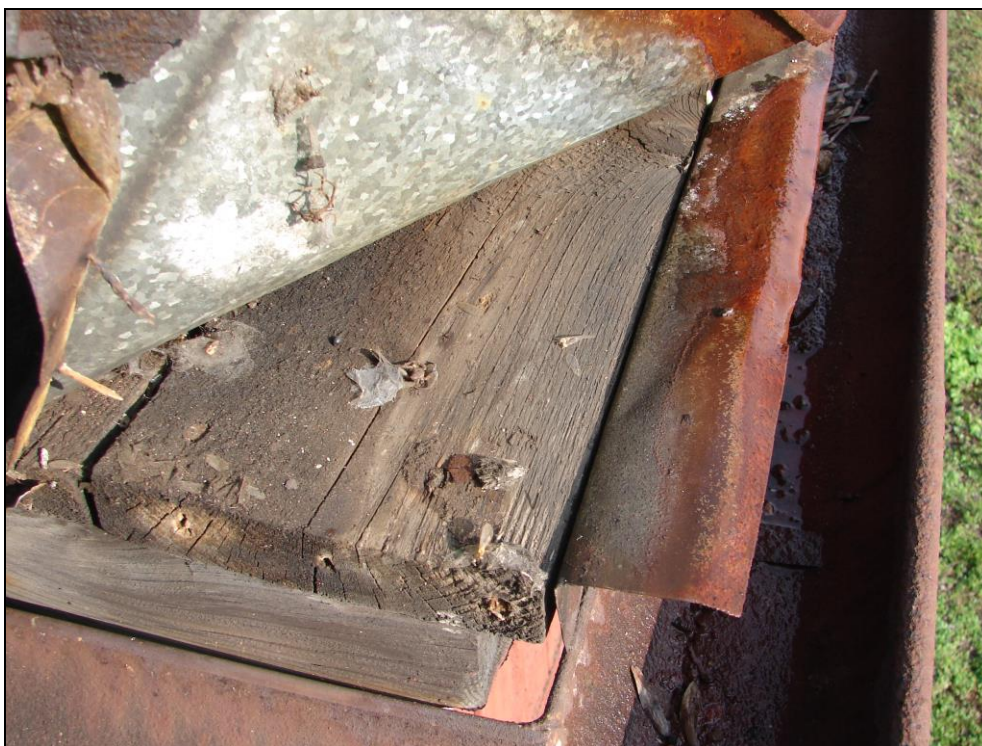
Foto 63: SO 11-45-01, ŽST Čachovice, stavědlo č. 2, střecha, střešní krytina z pozinkovaného plechu je uložena přímo na dřevěné bedněni (na bedněni není asfaltová lepenka)
