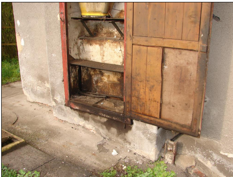
Foto 46 a 47: SO 11-45-01, ŽST Čachovice, stavědlo č. 2, 1.NP, nika v průčelí směrem k trati (foto 1), dřevěné dveře, lokální a povrchové zasažení omítek olejovými produkty, zasažení je zanedbatelné
